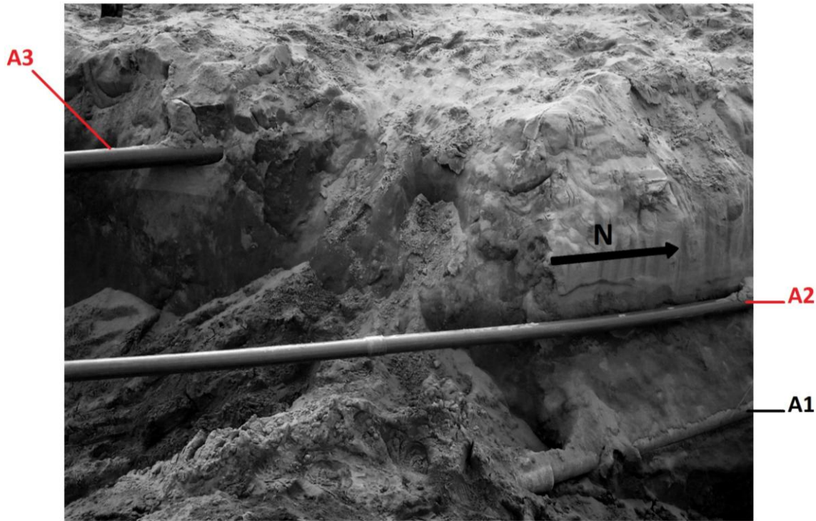
Figura 2 – Fotografia obtida durante a última atividade de manutenção na área de estudo. Por meio dela podem ser observados os três dutos de água (Marcas A1, A2 e A3) localizados no levantamento com GPR realizado por Mota & Oliveira Jr (2013). Perceba que o primeiro duto (de baixo para cima, A1) está posicionado imediatamente abaixo do duto central (A2). Veja também as Figuras 3, 4 e 6.
